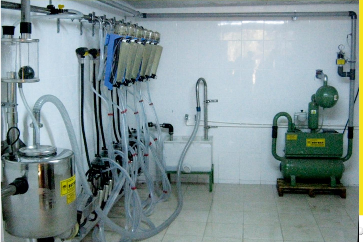
POMPA DAİRESİ UNITÉ DE POMPE
